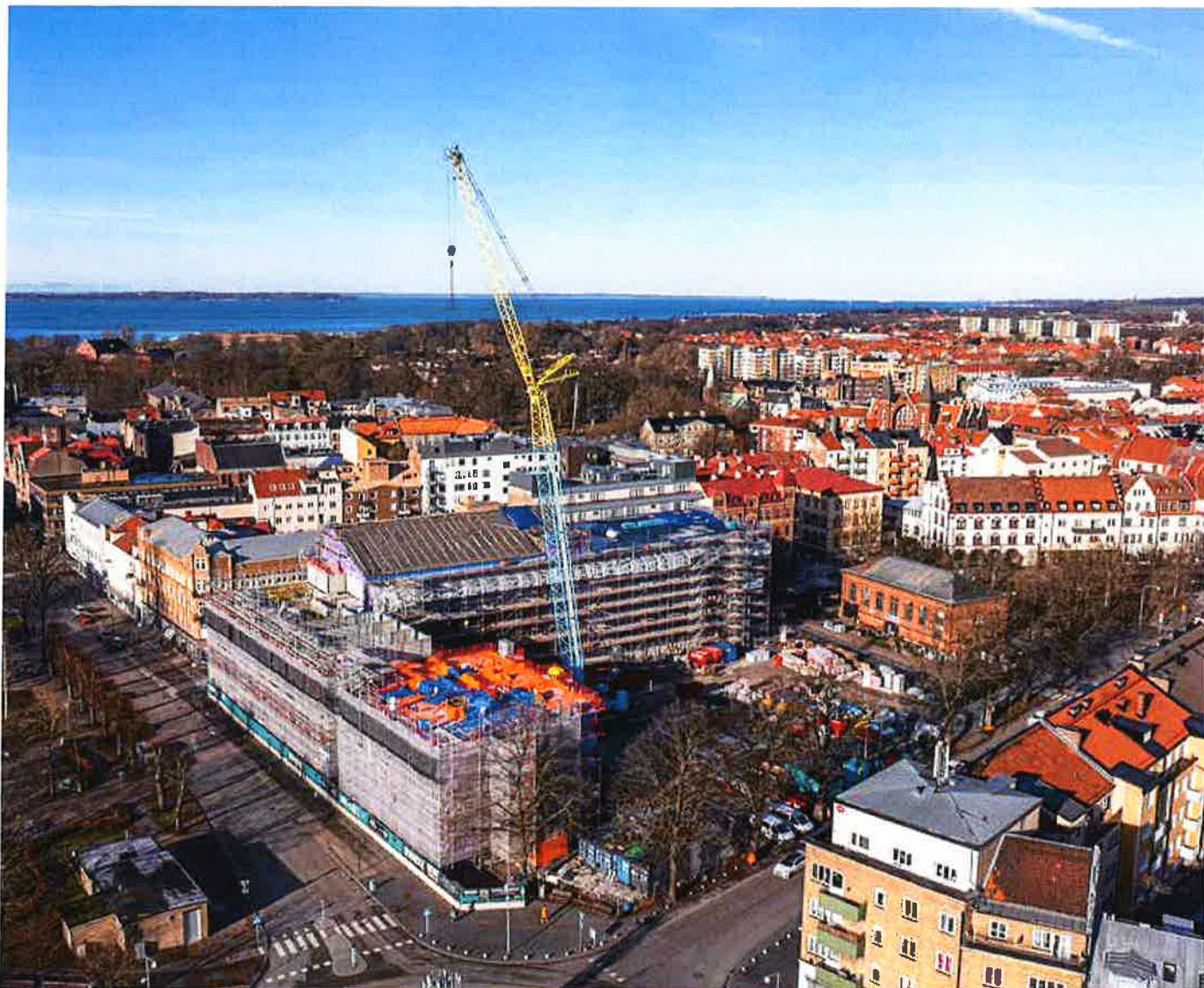
Trygghetsboendet, Kvarteret Jäntan under uppbyggnad.
